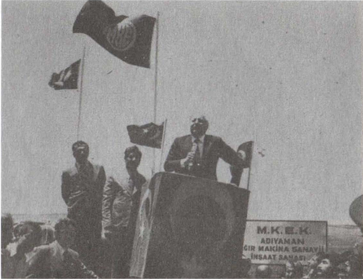
Adıyaman'da Bir Ağır Sanayi Tesisinin Temelini Atarken
